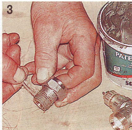
Снятый с клапана хвостовик с надетой накидной гайкой вкручивают в пробку радиатора. Резьбовое соединение уплотняют льняной прядью и сантехнической пастой или герметиком.
