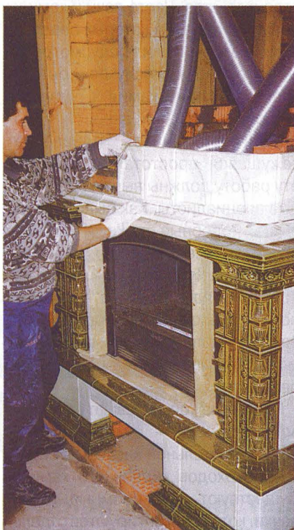
В качестве воздушных каналов калифорнийской системы камина используют гибкие металлорукава.
