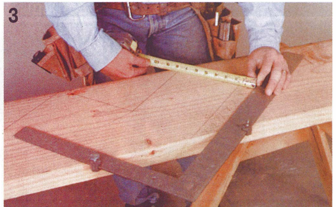
На нижнем конце тетивы из высоты первой ступени необходимо вычесть толщину доски ступени будущей лестницы.
