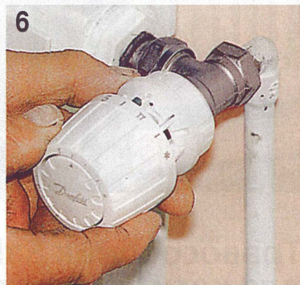
Сняв защитный колпачок с клапана, настраивают термозлемент на максимум, затем надевают и уверенно нажимают на термоголовку в направлении клапана до щелчка.
