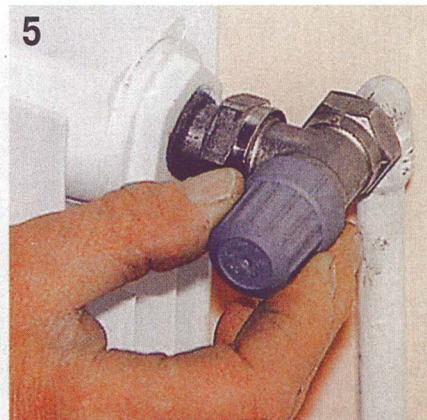
Накидную гайку накручивают на корпус клапана и затягивают. Заранее проверяют, нет ли грязи на клапане и хвостовике. Дополнительной герметизации для этого соединения не требуется.
