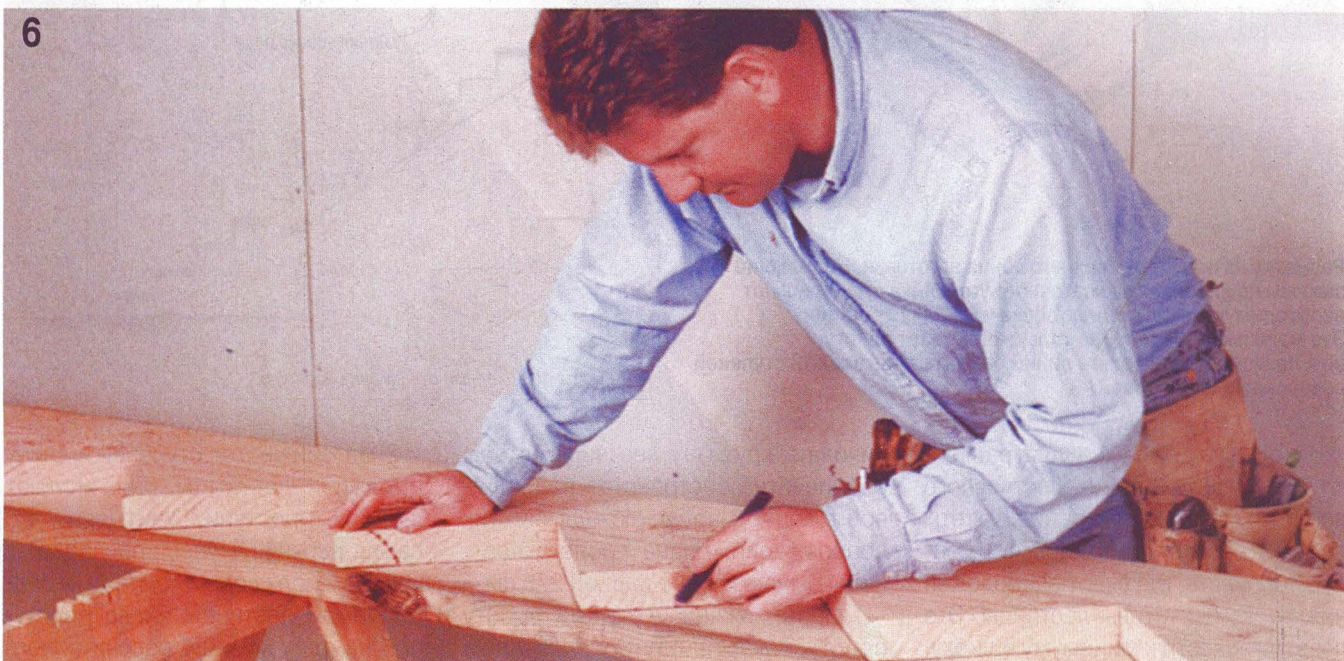
Готовая первая тетива служит шаблоном, по которому размечают вторую.
