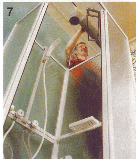
Когда кабина встала на свое окончательное место, крепят вентиляционную трубу. Если вы собираетесь передвигать душ, трубу надо будет демонтировать.
