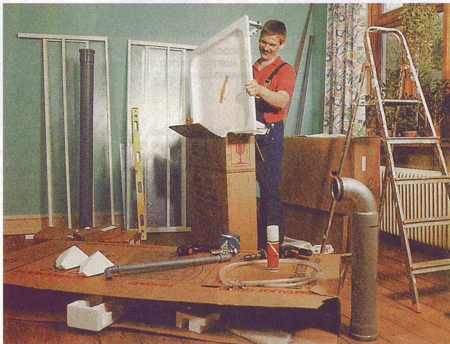
Первым делом надо распаковать душевую кабину. Отдельно придется покупать водопроводные, сточную и вентиляционную трубы.
