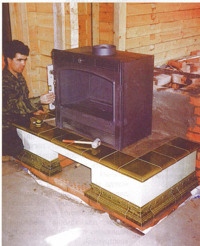
Один из начальных моментов работы. На цоколе устанавливают камин-кассету, контролируя положение строительным уровнем.
