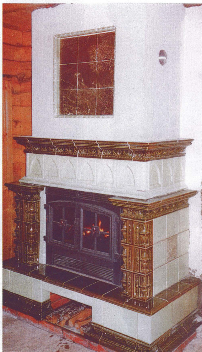
Конструкция классического камина с чугунной топкой-вставкой, облицованного изразцами.
